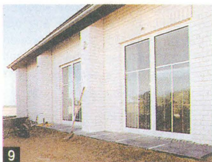
9 Сухой раствор для основания отсыпают во время укладки плит.
