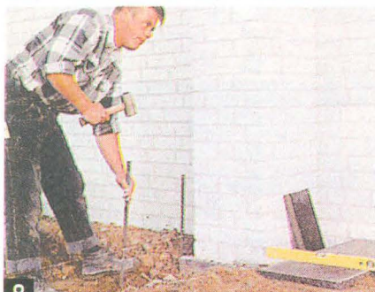
8 При укладке плит следует уделить внимание ровности рядов.
