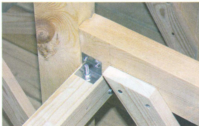
Узлы крепления опор — сборно-разборные.
