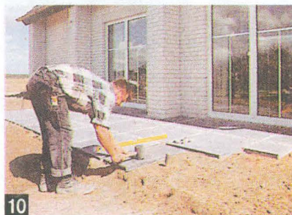
10 Уложенные плиты совмещают по уровню. Там, где необходимо, их подбивают резиновым молотком.
