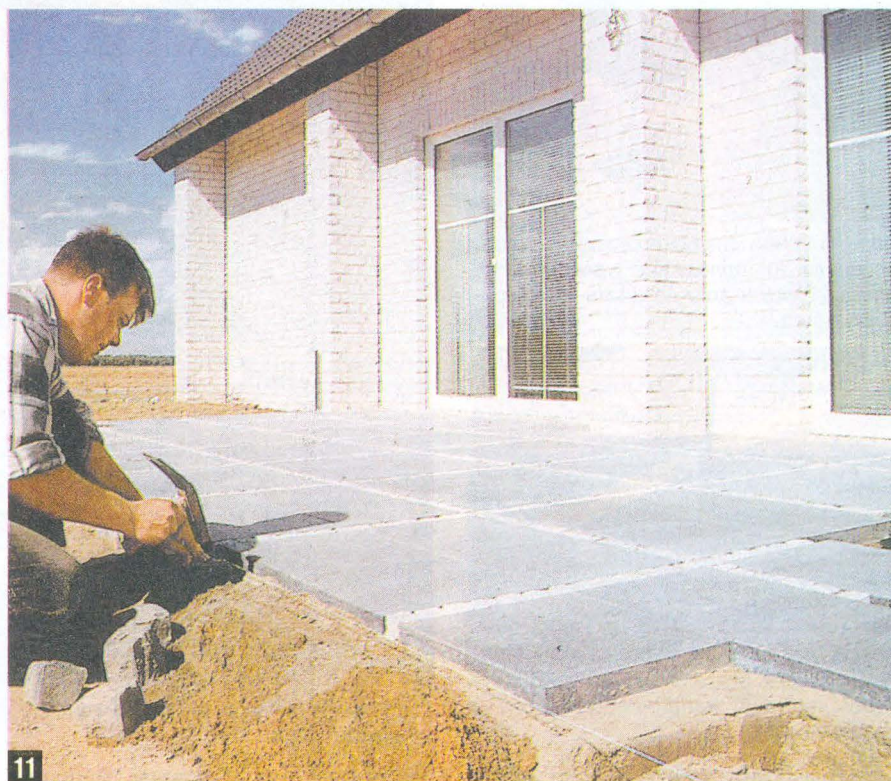
11 Пол террасы обрамляют бордюром из более крупного булыжника, создавая за ним надёжную «подпорную стенку».
