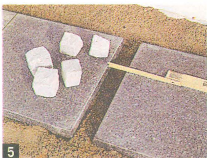
5 Между шлифованными плитами размерами 40 × 40 см кладут гранитный булыжник размерами 4 × 6 см.
