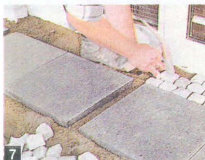
7 Все промежутки заполняют мелким булыжником из природного камня, подбивая его специальным молотком.
